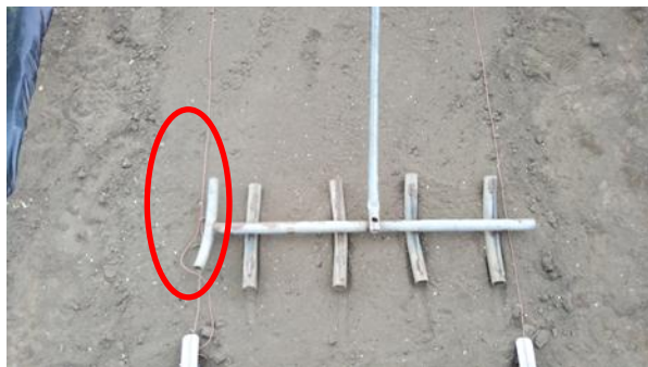
端部を縄に沿わせながら手前に引きます
